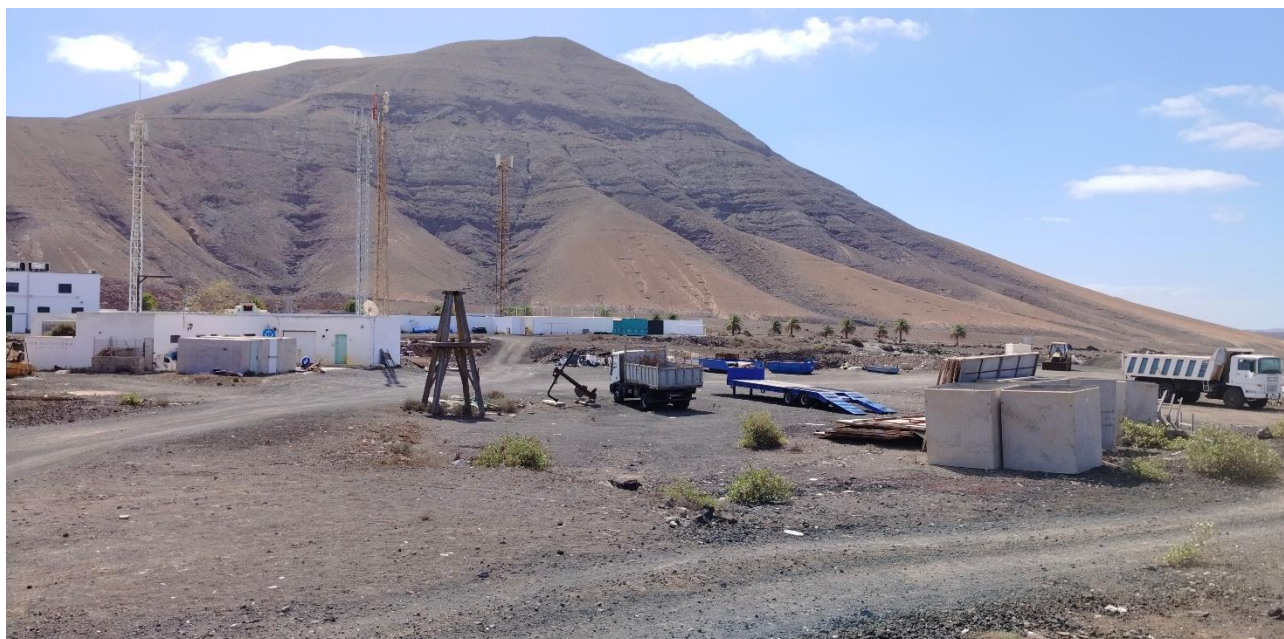
Figura 4. Molino sin palas, dentro del espacio destinado al acopio de materiales inertes. Fuente: Elaboración propia.
