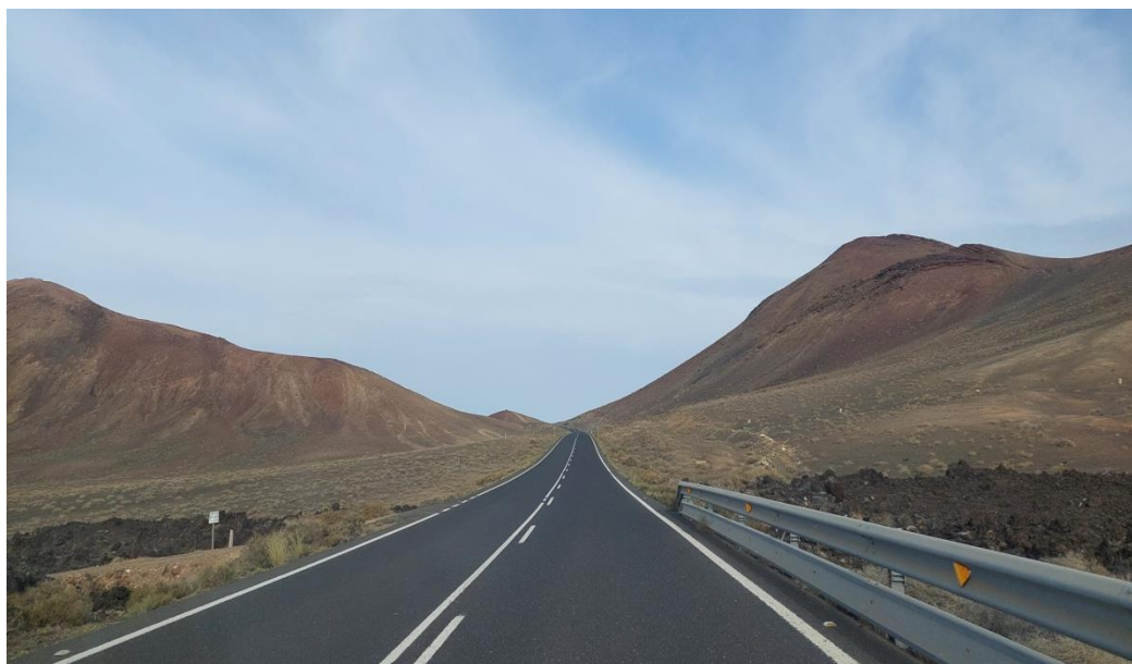
Figura 20. Vía LZ-704, en el interior del Parque Natural de Los Volcanes. Fuente: Elaboración propia.
