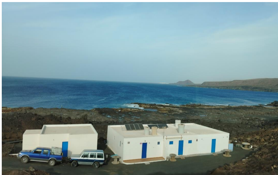
Figura 52. Depósitos de agua en azoteas de las viviendas de Tenesar. Fuente: Elaboración propia.
